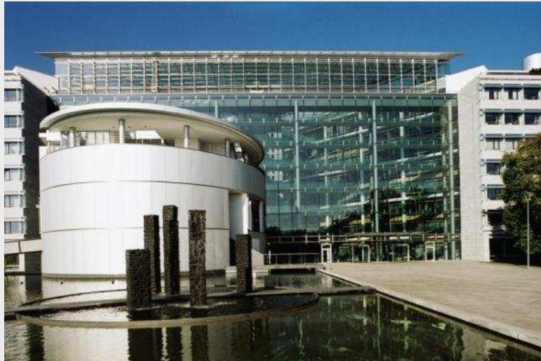
Boehringer Ingelheim Center Unsere Unternehmenszentrale in Ingelheim
